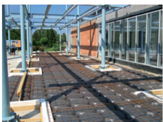
7 Položení tepelné izolace + dalších vrstev
