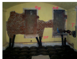
2 Příprava vyvedení odvětrávacích komínků z dutiny.
