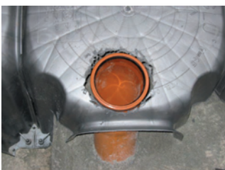
3 Uložení vedení odpadové kanalizace.
