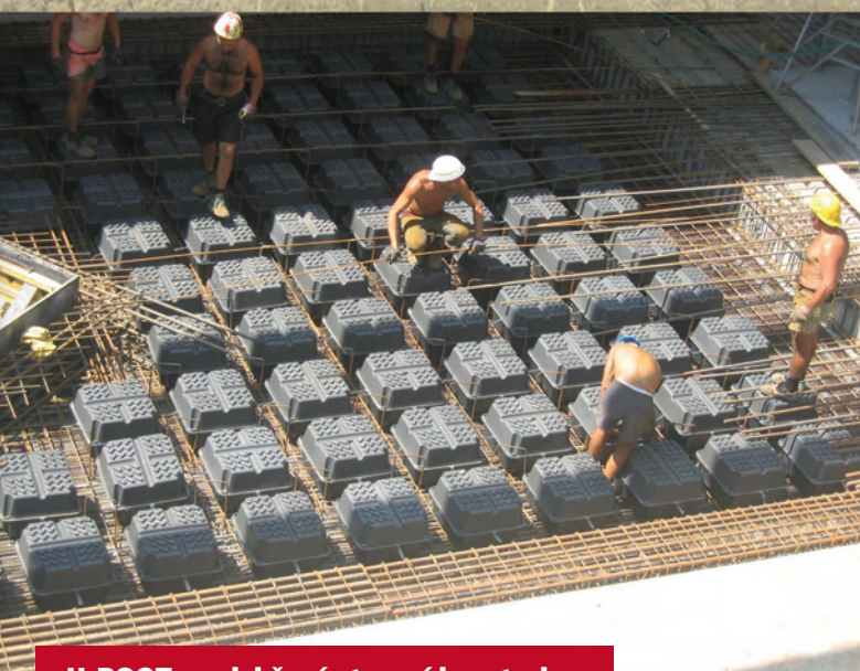
U-BOOT – vylehčené stropní konstrukce
