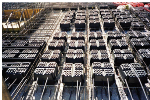
Jednoduchý U-Boot element = výška od 10 cm až do 28 cm
