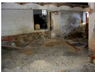
3 Uložení vedení odpadové kanalizace.
