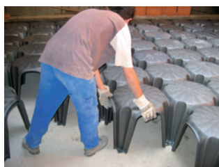
6 Zalití elementů betonem a vylití desky nad elementy.
