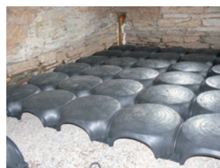
6 Zalití elementů betonem a vylití desky nad elementy.
