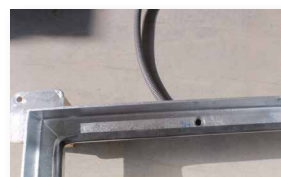
V rámu poklopu je otvor pro nasazení odtokové hadice na vodu, která do rámu nateče. Používá se zejména v případě venkovní instalace.
